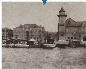
門司港第一船溜り(明治43年)
