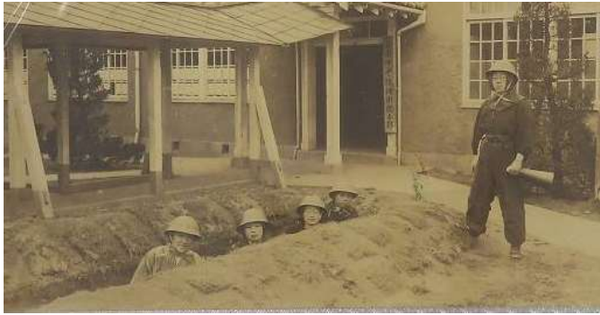
▲ 昭和10年代頃 学校敷地内での防空壕設置 （西南女学院）
